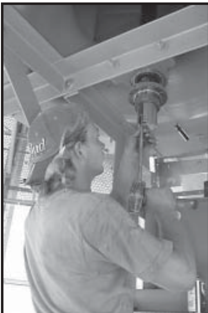
Photo 14-19 Placing Fan Hub Key in Fan Hub.
