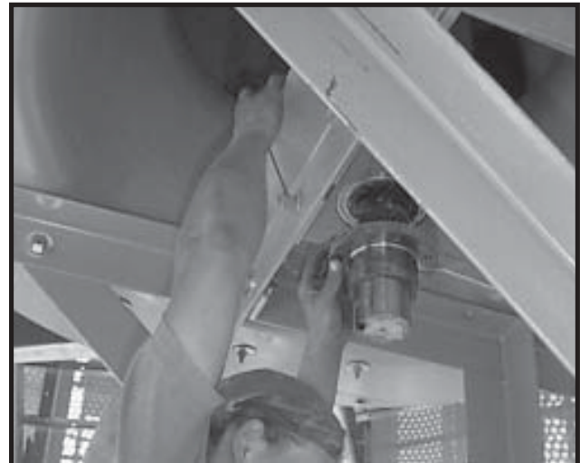
Photo 14-18 Sliding Fan Hub on Fan Drive Shaft.
