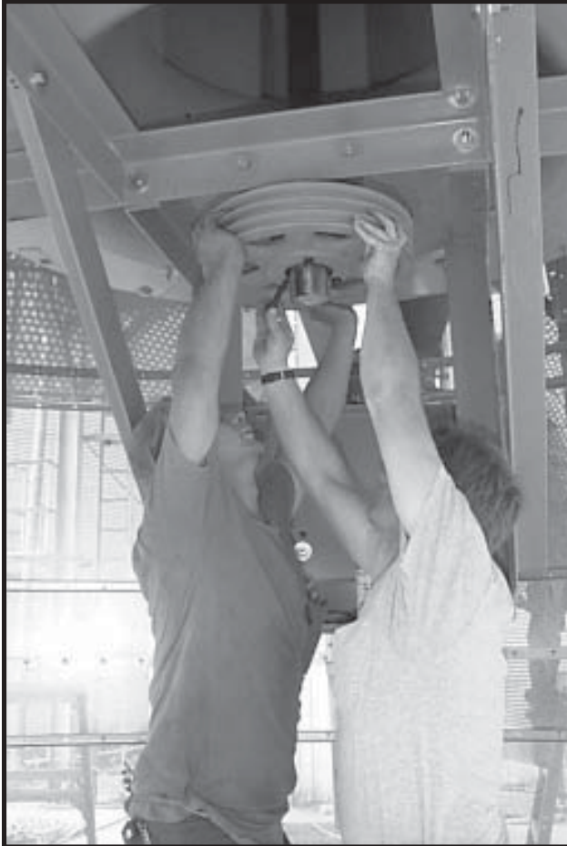
Photo 14-21 Sliding Fan Sheave on Fan Drive Shaft.
