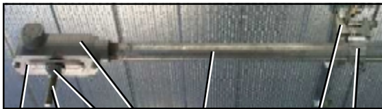
Plenum high limit conduit (plenum pipe).
